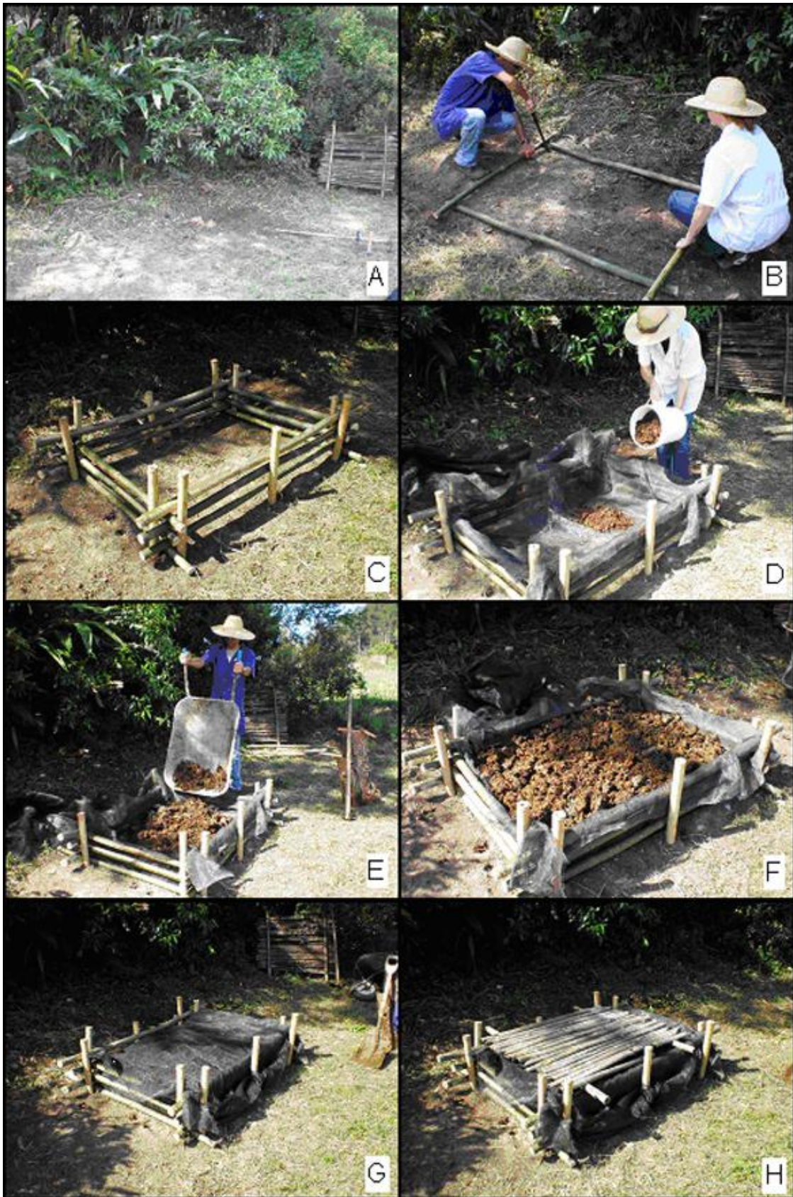
Figura 1. Seqüência de montagem do minhocário campeiro de bambu: a) escolha da área; b) marcação do minhocário; c) formação das paredes e travamento das cabeceiras com
